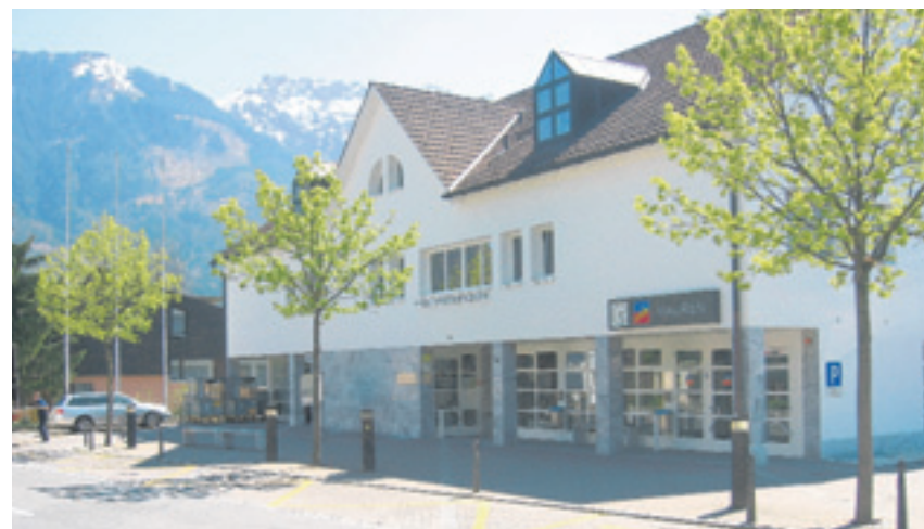
Sanierungsbedürftig: In Mauren werden in den kommenden Wochen die Busbuchten erneuert. Bild: pafl
